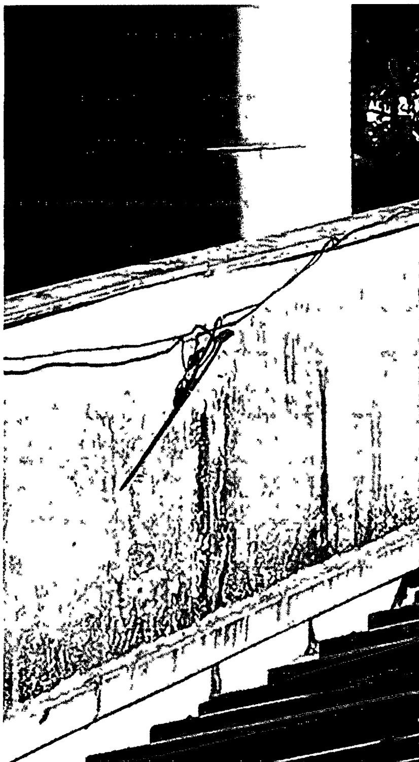
FIGURA 4 - CAPTOR E CONDUTOR EM SITUAÇÃO INADEQUADA, SOLTO EM CIMA DE CALHA METÁLICA E EM CONTATO A PLATIBANDA.
